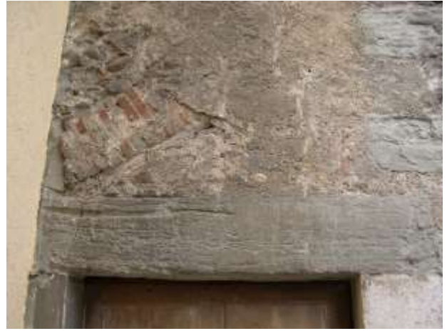
Fig. 14. Face sud-ouest, arc de décharge au-dessus du linteau de la porte.
