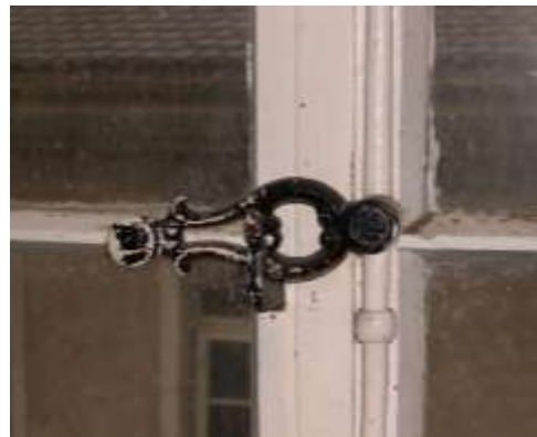
Fig. 22. 1 er étage, pièce avant, baie, poignée en fonte.
