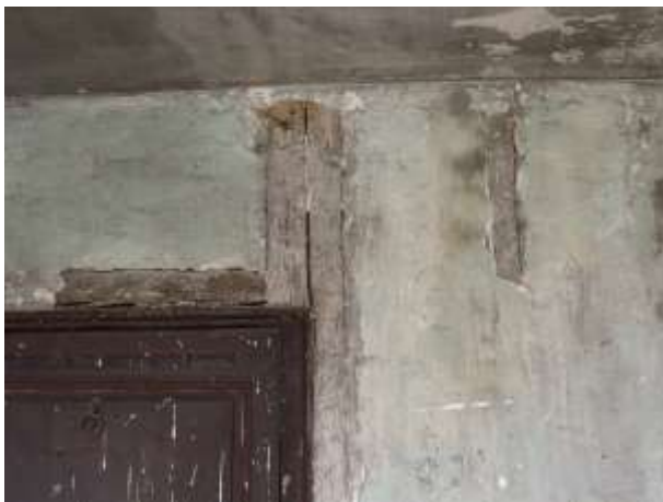
Fig. 31. 2 e étage, pièce principale, paroi interne, pan de bois.
