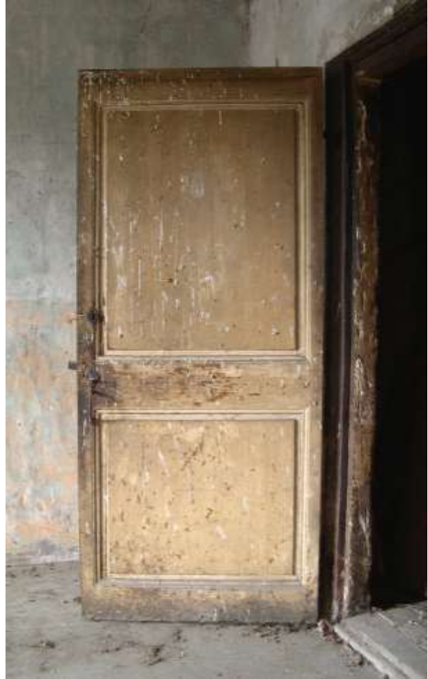
Fig. 30. 2 e étage, pièce principale, porte, face externe.
