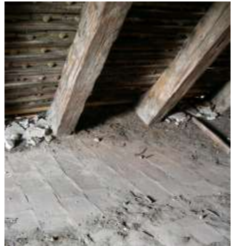
Fig. 36. Combles, sol en carreaux.
