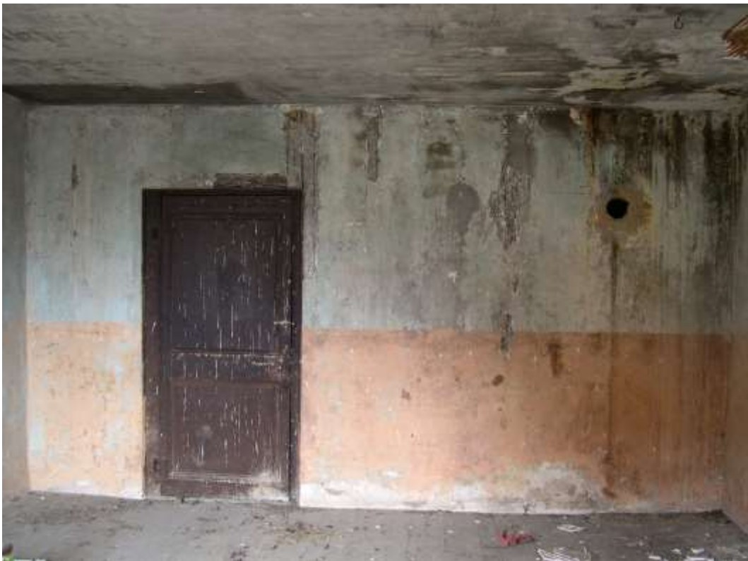
Fig. 28. 2 e étage, pièce principale, face interne nord-ouest.
