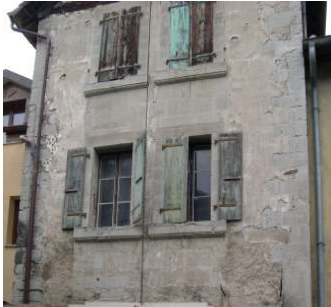
Fig. 10. Façade sud-est, baies supérieures.
