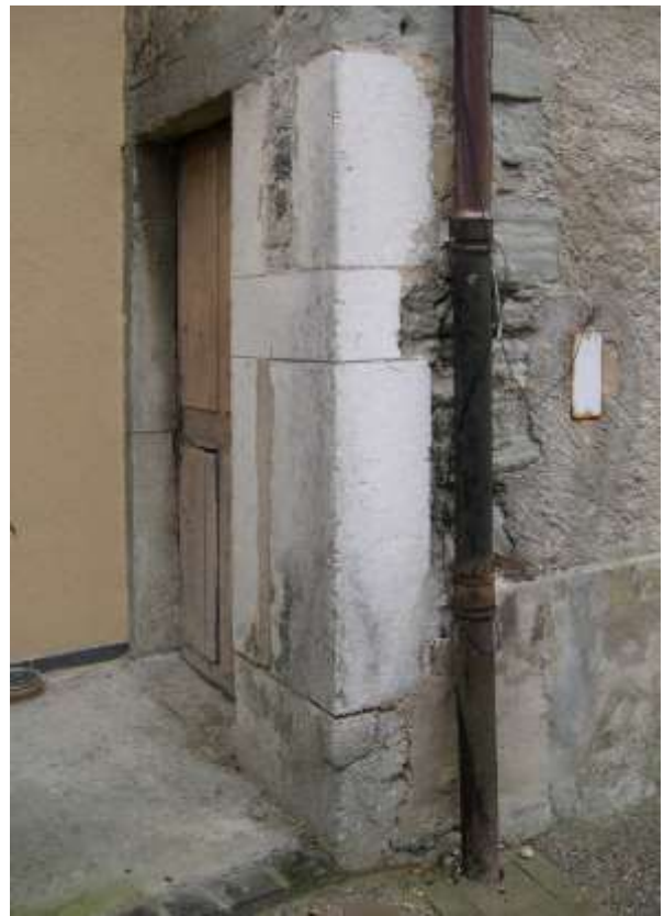
Fig. 16. Face sud-ouest, porte et chaîne d'angle.
