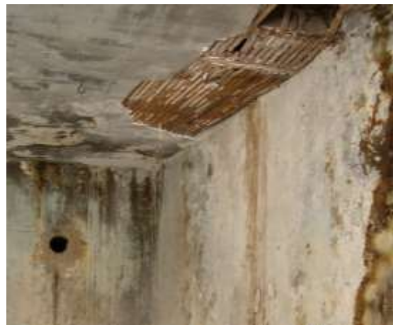
Fig. 32. 2 e étage, pièce principale, plafond plâtré sur lattis.
