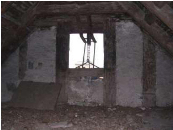
Fig. 35. Combles, pan de bois du pignon sud-est.
