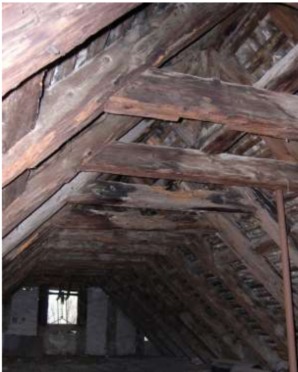
Fig. 37. Combles, charpente à chevrons formant fermes.
