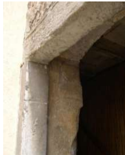
Fig. 18. Rez-de-chaussée, congé dans l'embrasure et traces d'arrachage.
