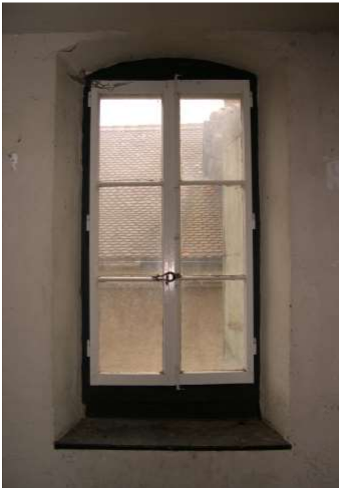
Fig. 21. 1 er étage, pièce avant, baie.
