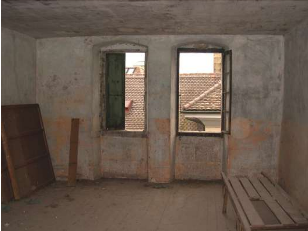
Fig. 27. 2 e étage, pièce principale, côté sud-est.
