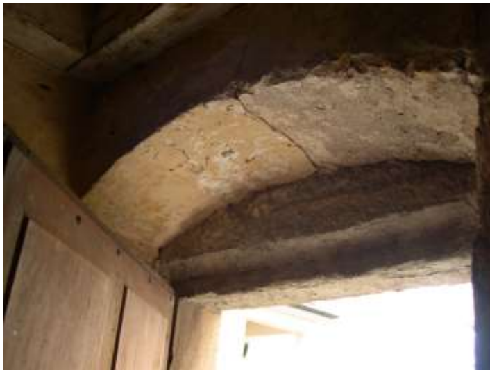
Fig. 17. Rez-de-chaussée, linteau interne.
