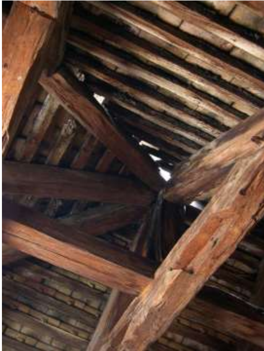
Fig. 43. Combles, charpente, poinçon portant l'épi de faitage.
