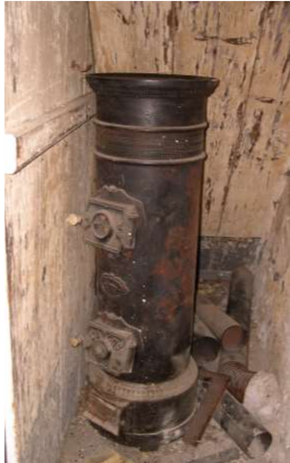
Fig. 24. 1 er étage, pièce arrière, fourneau en fonte.
