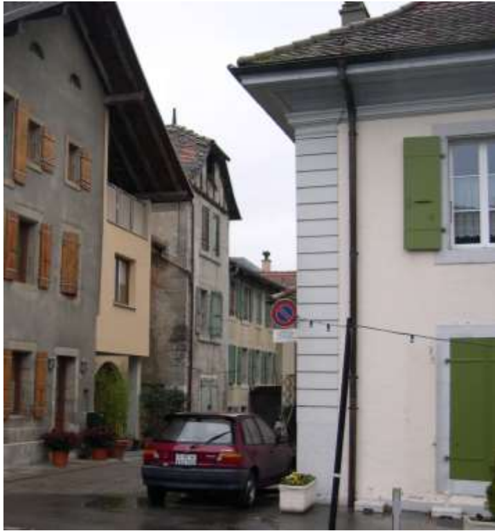
Fig. 1. Situation côté sud-est.
