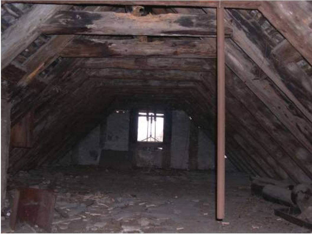
Fig. 33. Combles, charpente à chevrons formant fermes, côté sud-est.
