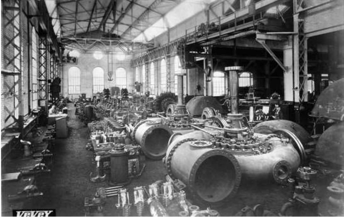
Fig. 6. Intérieur de la halle des ACMV, ajustage des turbines, vers 1942 (Musée historique de Vevey, Album 12, n° entrée 3252, *Ateliers de constructions mécaniques de Vevey S.A.*).
