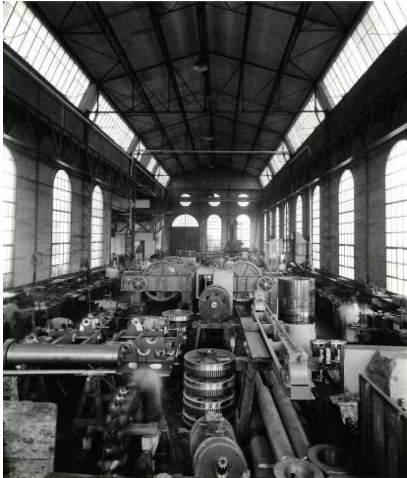
Fig. 24. Intérieur de la halle, montage des turbines, vers 1942 (Musée historique de Vevey, Album 12, n° entrée 3252, *Ateliers de constructions mécaniques de Vevey S.A.*).
