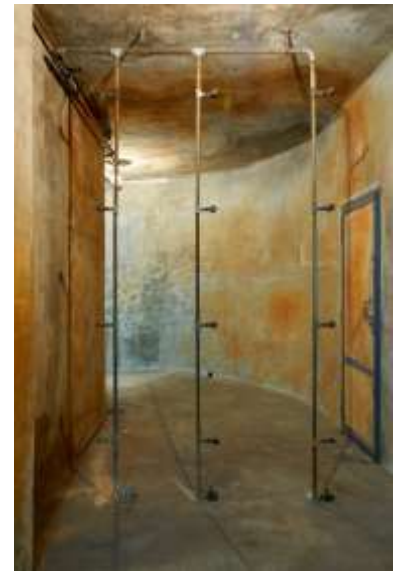
Fig. 85. Sous-sol, humidification de l'air par vapeur d'eau.
