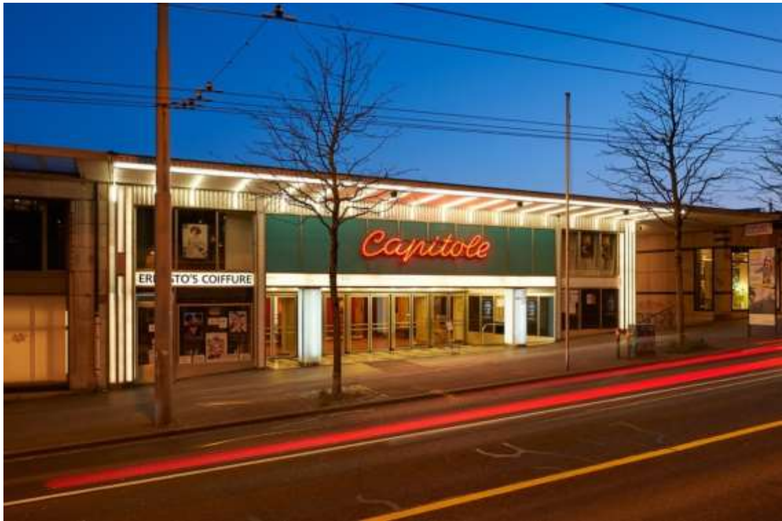
Fig. 56. Façade nord, sur l'avenue du Théâtre.
