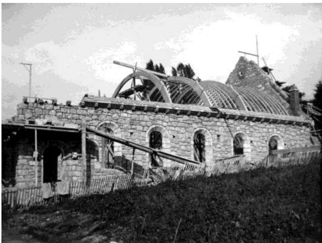
Fig 11. Chantier de la chapelle du Saint-Rédempteur, octobre 1915 (archives de la paroisse du Saint-Rédempteur). A remarquer la construction de la voûte en bois cintré.
