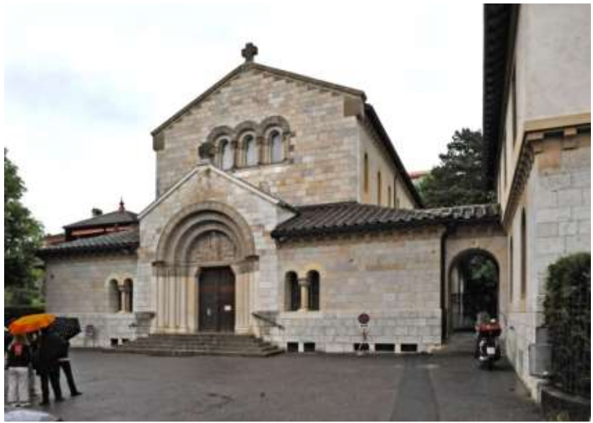
Fig. 47. Eglise catholique St-Paul de Grange-Canal, Adolphe Guyonnet architecte, 1915 (photo Adrien Bürki, Unil, 2011).
