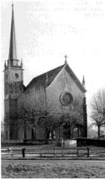
Fig. 46. Eglise catholique de Bottens, Henri Perregaux architecte, 1843-1848 (extrait de BISSEGER, Paul, D'ivoire et de marbre. Alexandre et Henri Perregaux. 1770-1850 , Lausanne : Bibliothèque historique vaudoise, 2007, p. 247).
