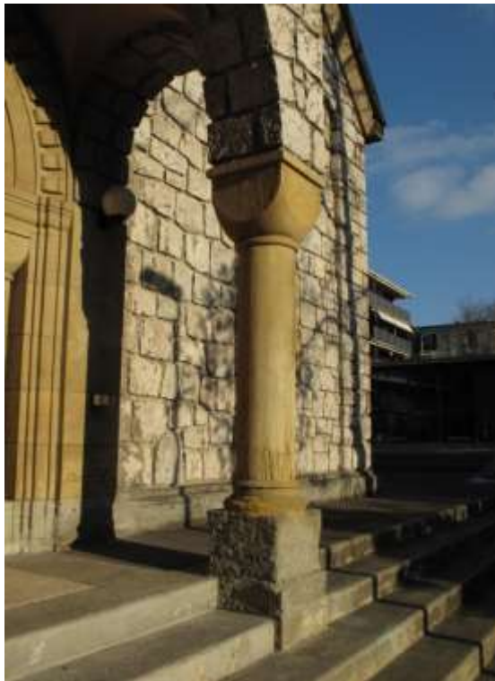
Fig. 19. Porche d'entrée sur la façade Sud (photo Bruno Corthésy, 2013).
