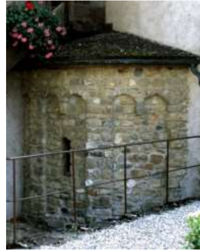
Fig. 51. Eglise de Bursins, absidiole Nord (photo Marcel Grandjean, Unil, 1994).
