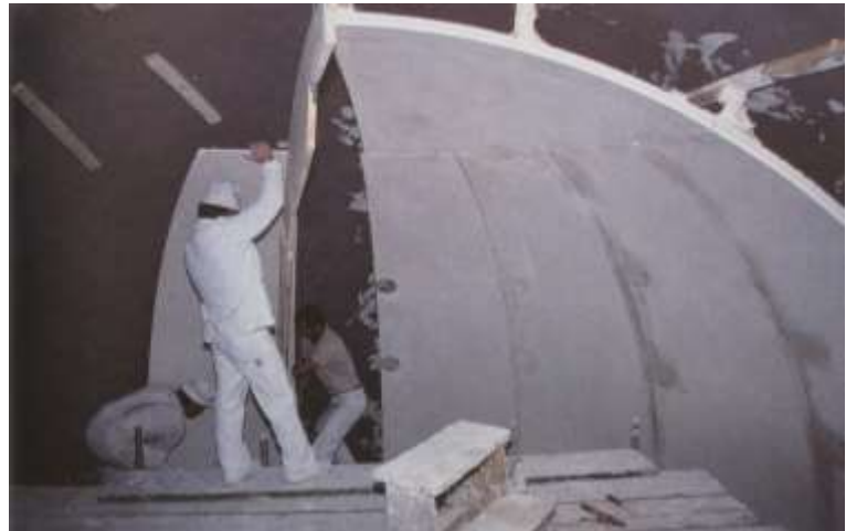
Fig. 70. Pose des éléments préfabriqués dans l'abside (extrait de MONTI, op. cit. ).
