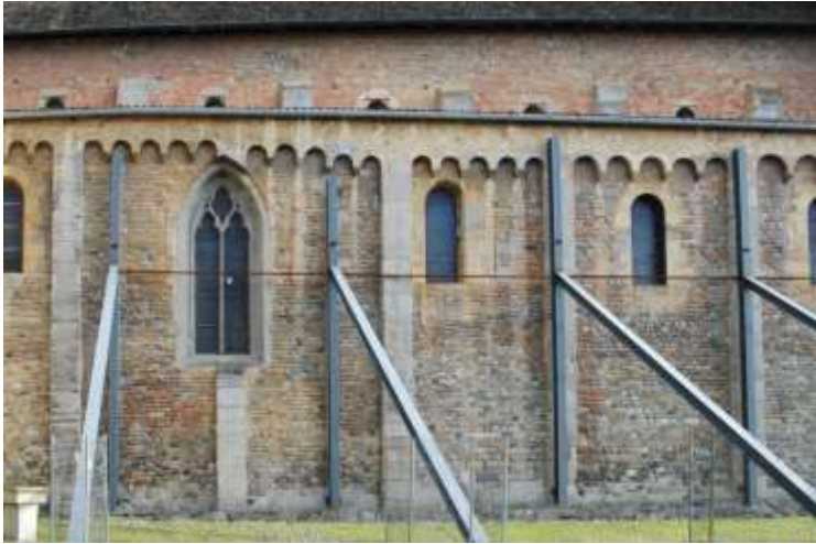
Fig. 50. Abbatale de Payerne, façade Nord (photo Vanessa Bilvin, Unil, 2012).
