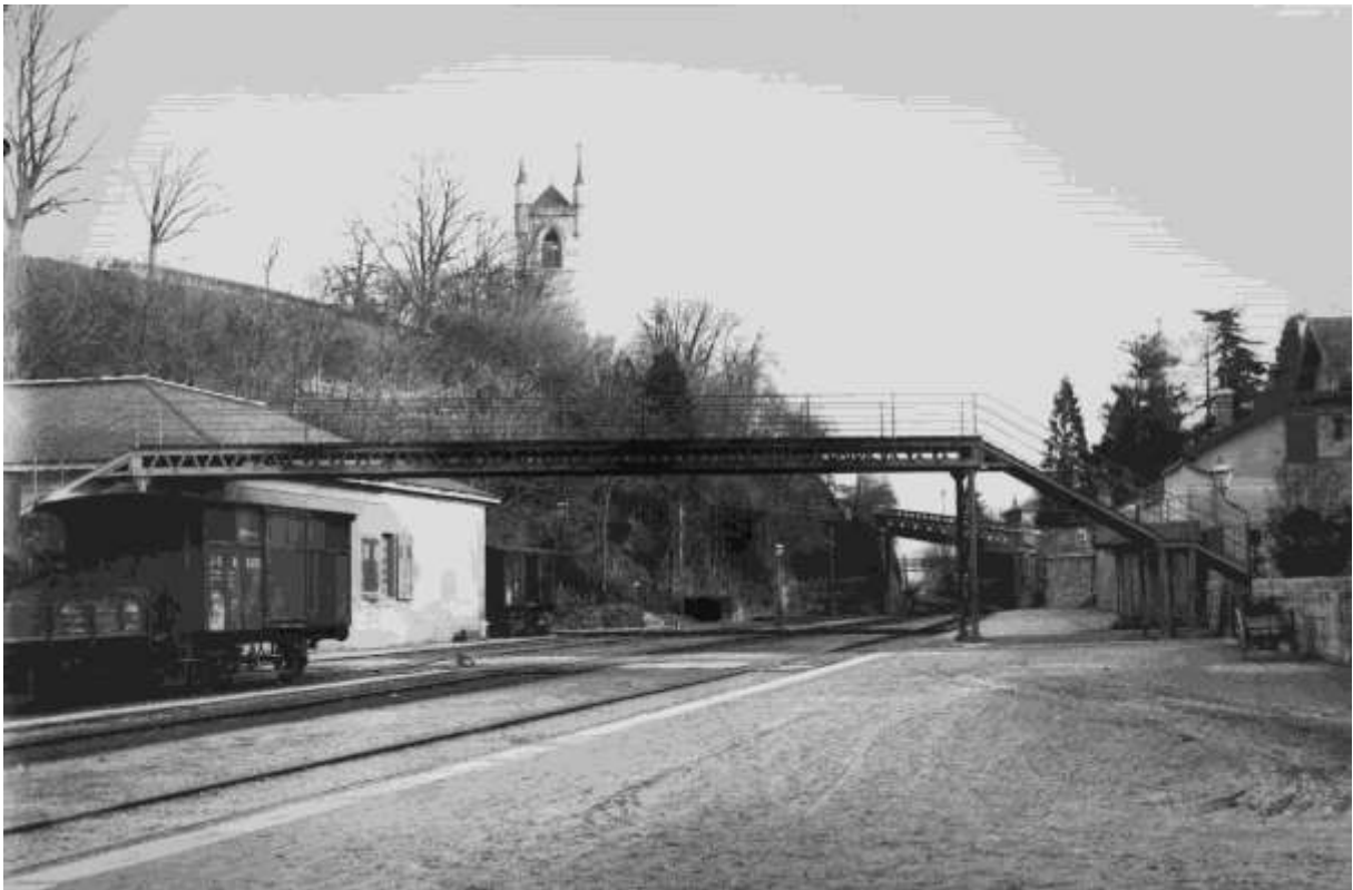
Fig. 20. La passerelle piétonne construite après 1876 dans le prolongement de la rue des Bosquets (MHV). A gauche, le vaste bâtiment de plan carré, indiqué sur le plan de 1876 et démolé en 1904.
