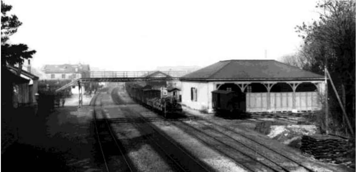
Fig. 21. La gare après 1876 (MHV). A droite, le dépôt situé juste à côté de la passerelle. Le déplacement des wagons se fait latéralement.
