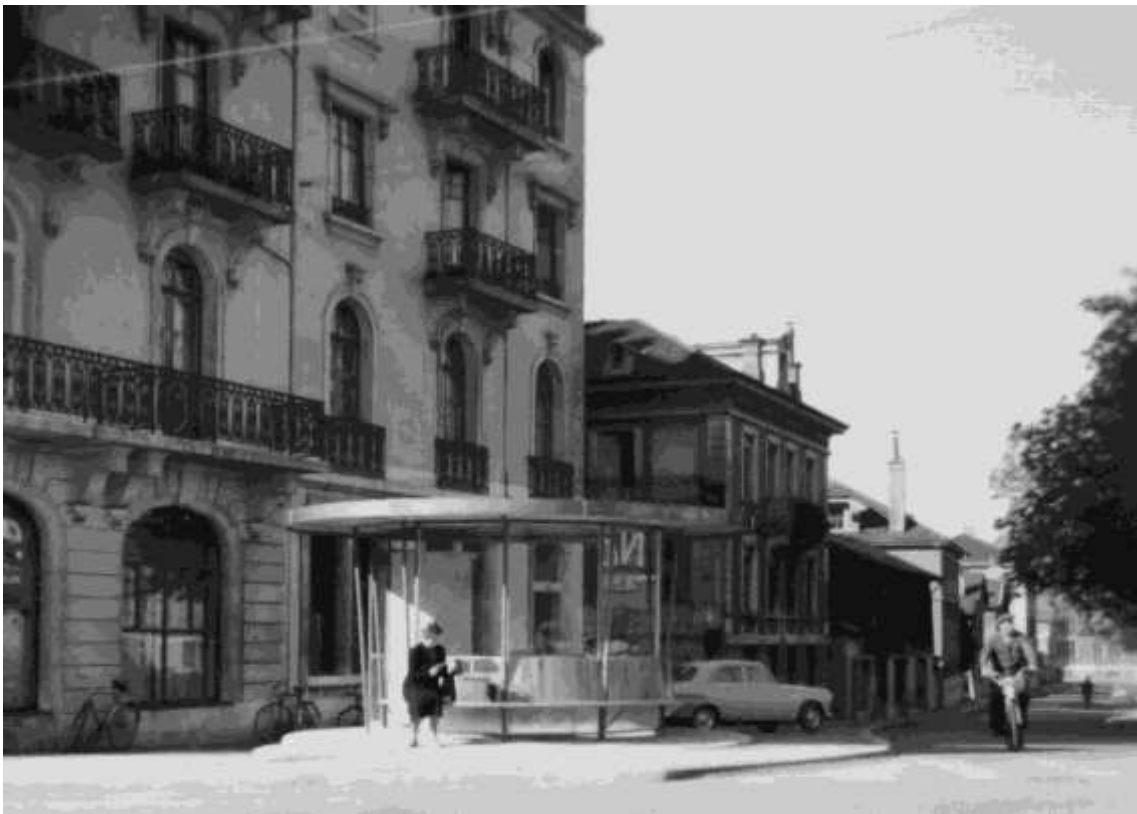
Fig. 62. Nouvel abri des trolleybus en haut du quai de la Veveyse, Eugène Blauer et Reynold Minacci architectes, 11.4.1959 (Directions des travaux, MHV).
