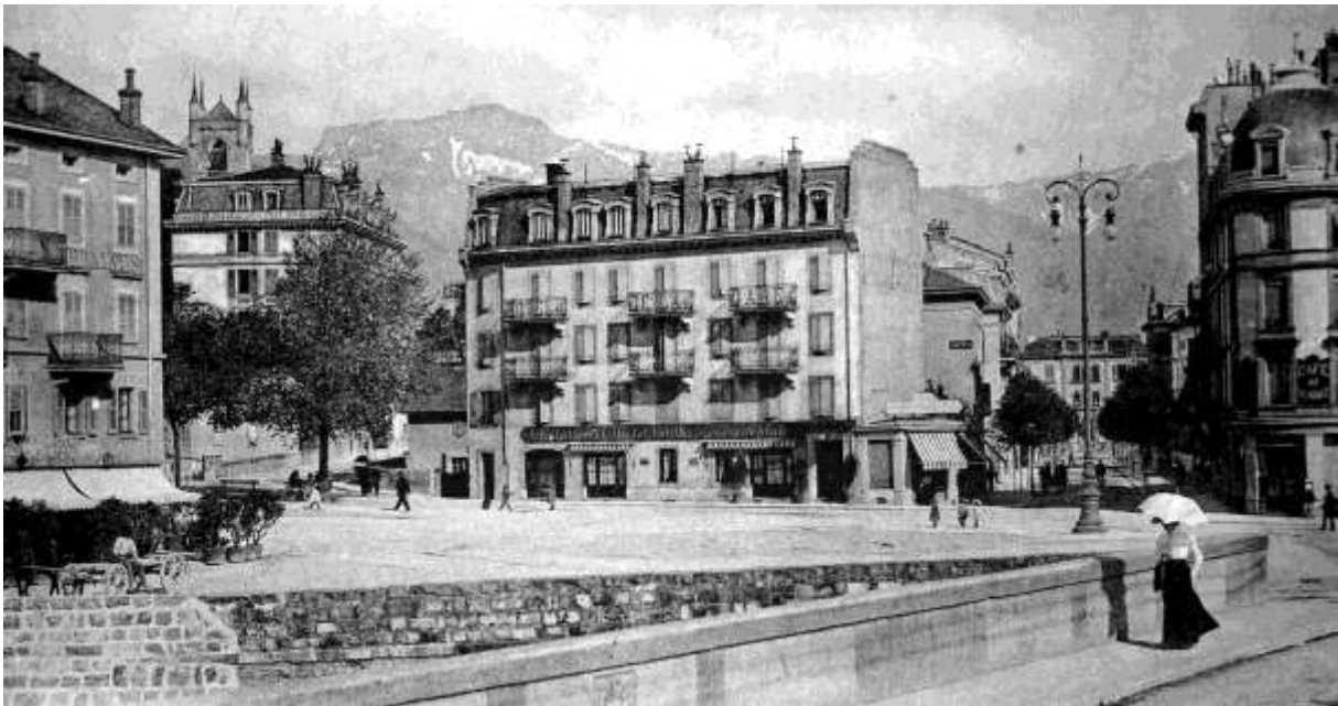
Fig. 26. Le front est de la place de la Gare après le percement de la rue des Communaux et de l'avenue de la Gare en 1889 (MHV). Au centre, l'hôtel de la Gare surélevé en 1890, à gauche l'hôtel de Famille construit en 1890, tout à gauche l'hôtel de la Poste et tout à droite le café du 10 août.
