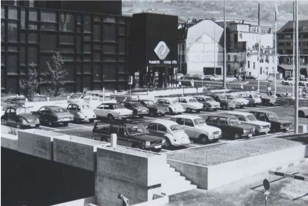
Fig. 75. Parking de 22 places installé sur la Veveyse en aval du pont Saint-Antoine, août 1973 (Direction des travaux, MHV).
