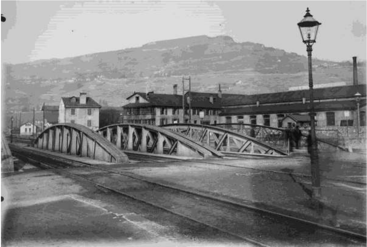
Fig. 14. Le pont construit sur le Veveyse pour permettre le passage des trains (MHV).
