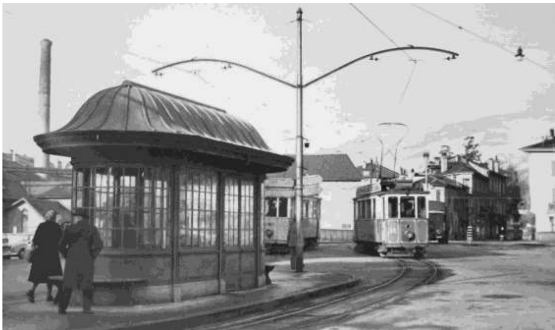
Fig. 43. Le kiosque abri pour la clientèle du tram, implanté au sud de la place de la Gare (MHV).
