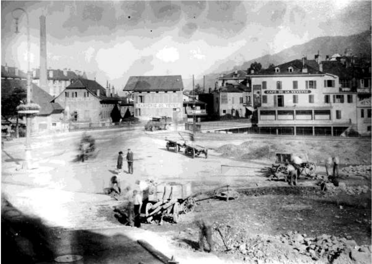
Fig. 48. L'emplacement de l'hôtel du Pont en 1923 après sa démolition (MHV).
