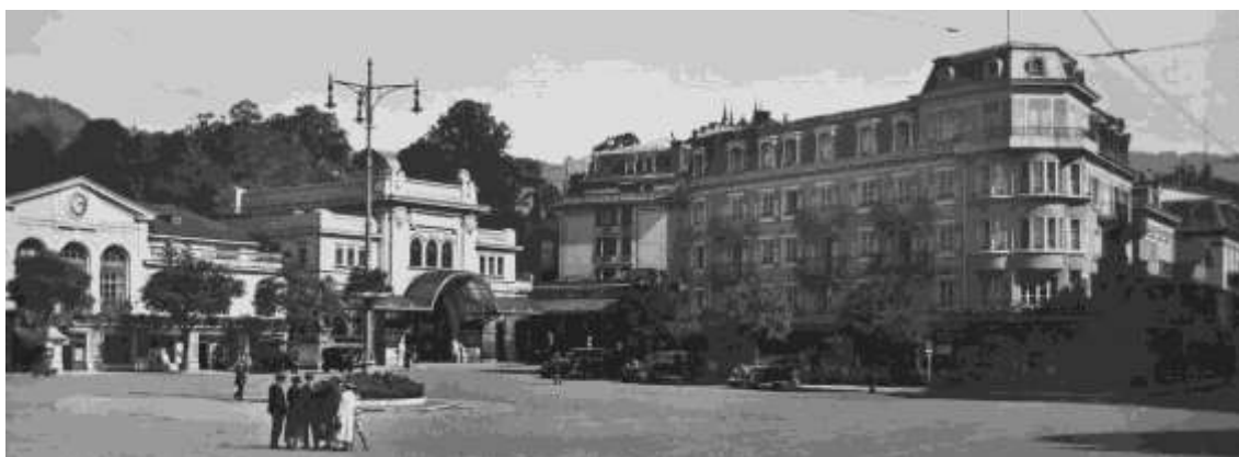
Fig. 40. La place de la Gare après 1911 (MHV). A droite, l'hôtel de la Gare a été transformé par l'architecte Charles Coigny en 1926 en le dotant notamment d'une rotonde à l'angle. Devant l'hôtel et devant la gare, les tilleuls plantés en 1910.
