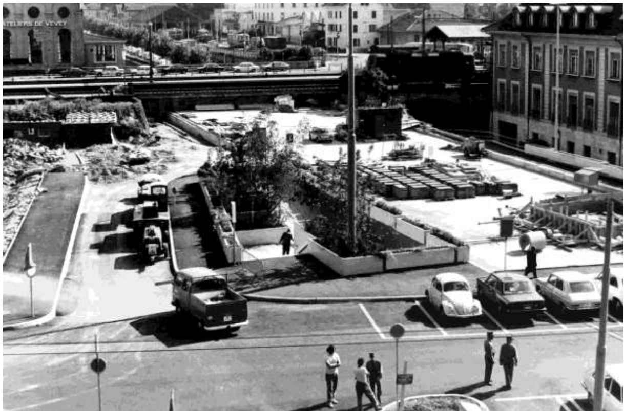
Fig. 74. Parking de 41 places installé sur la Veveysse en amont du pont Saint-Antoine et entrée du passage souterrain permettant de traverser l'avenue du Général-Guisan, août 1973 (Direction des travaux, MHV).
