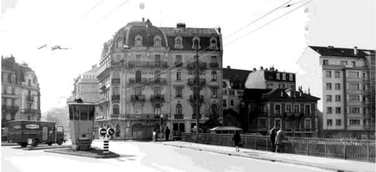
Fig. 63. « Mirador » installé en 1958 sur le pont Saint-Antoine, Georges Dufour architecte, 17.3.1966 (Directions des travaux, MHV).
