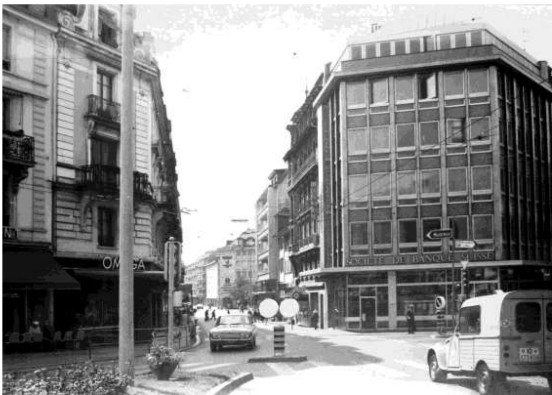
Fig. 72. L'immeuble de la Société de banque suisse construit en 1963 à l'angle de la rue de Lausanne et de l'avenue Paul-Cérésole (Direction des travaux, MHV).
