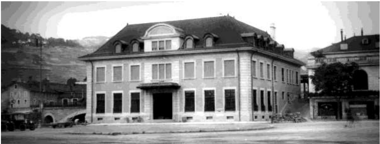
Fig. 49. La nouvelle poste construite en 1924 par les architectes Adolphe Burnat et Charles Coigny (MHV).
