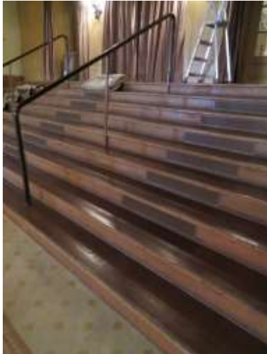
Fig. 130. Hall, escalier installé en 1947 pour accéder à la salle des fêtes.
