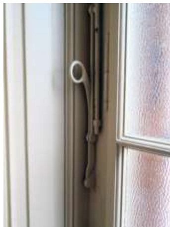
Fig. 136. Commande d'ouverture des impostes dans les corridors.
