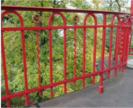
Fig. 108. Garde-corps au sud, au-dessus du jardin.
