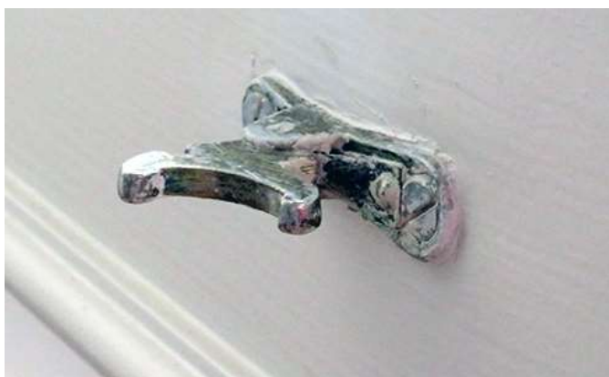
Fig. 104. Élément d'accrochage pour les fenêtres ouvertes.
