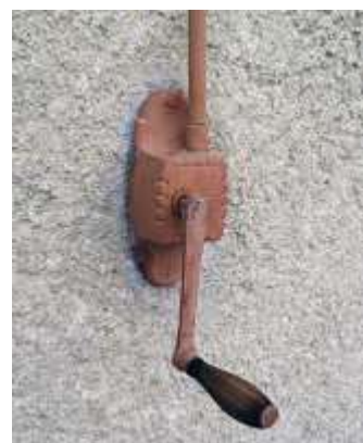
Fig. 105. Commande du parasol en tissu.
