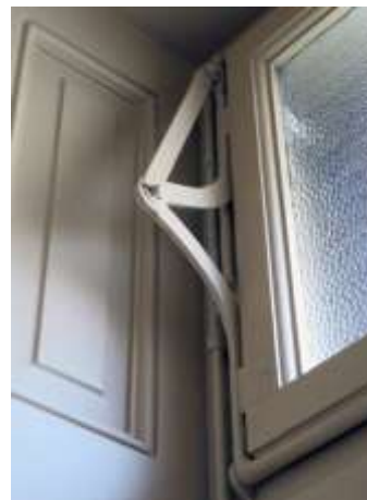
Fig. 137. Mécanisme d'ouverture des impostes dans les corridors
