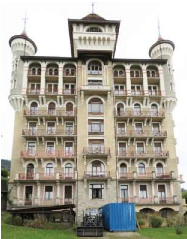
Fig. 45. Façade à l'extrémité ouest de l'aile ouest.
