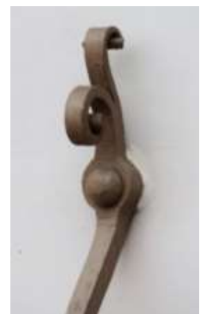
Fig. 42. Face sud de l'aile ouest. détail d'accrochage d'une marquise
