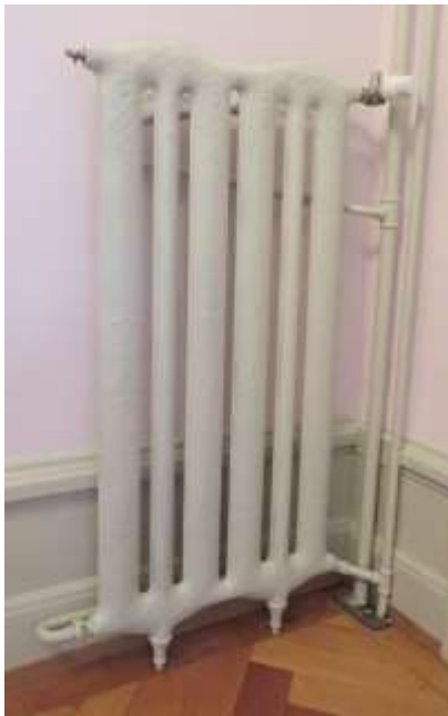
Fig. 97. Radiateur de marque Sulzer.
