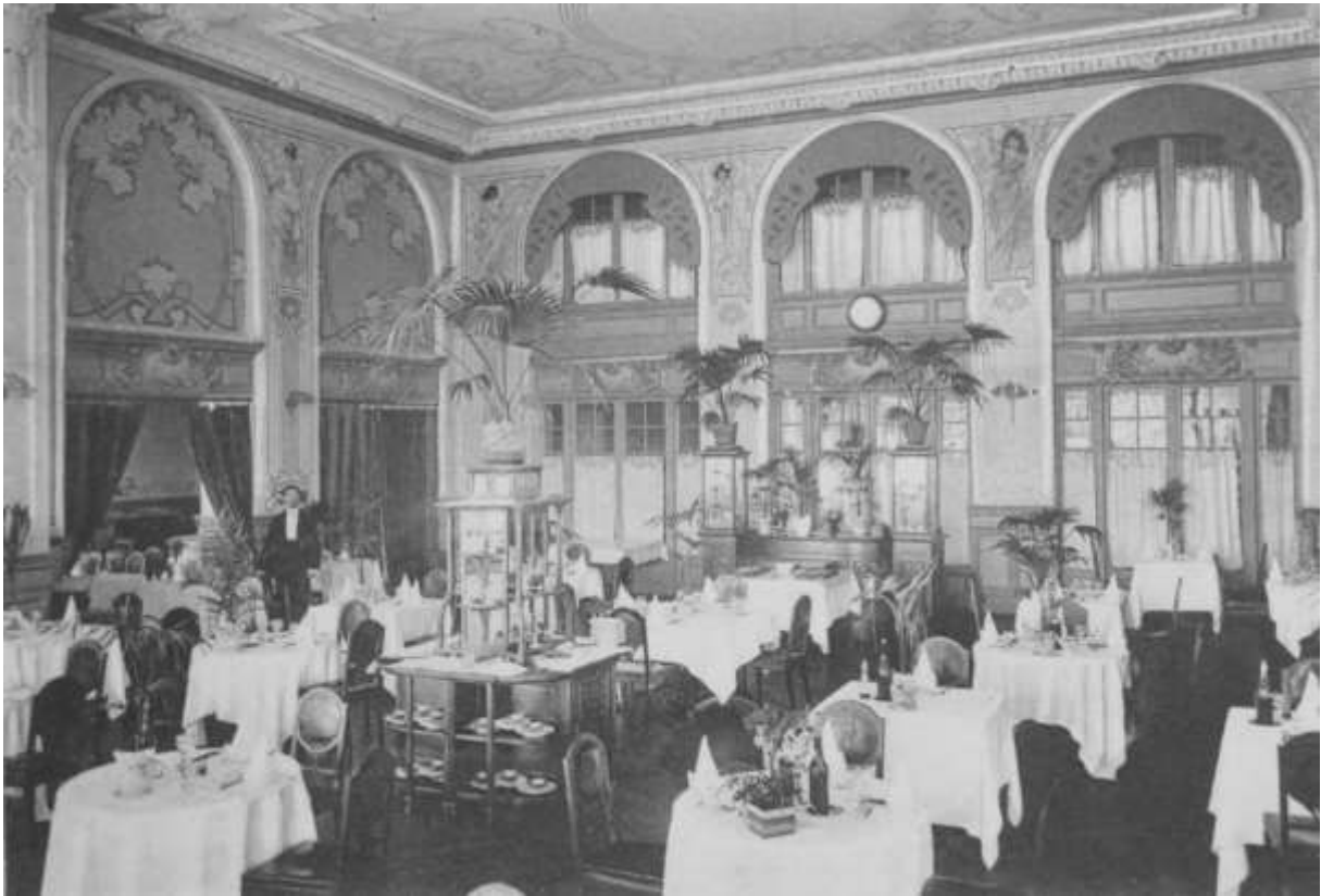
Fig. 16. Le restaurant situé sous le hall (AM, PP105/A303).
