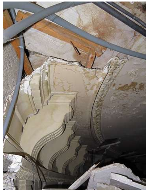
Fig. 129. Reste du décor 1900 au-dessus du faux plafond du vestibule.
