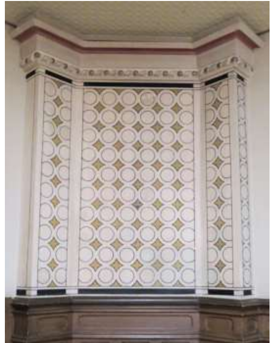
Fig. 56. Hall, décor peint, mur nord.
