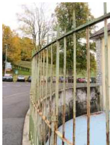
Fig. 111. Garde-corps à l'angle nord-est.
