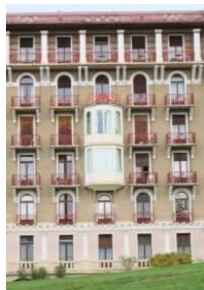
Fig. 34. Face sud de l'aile ouest.
