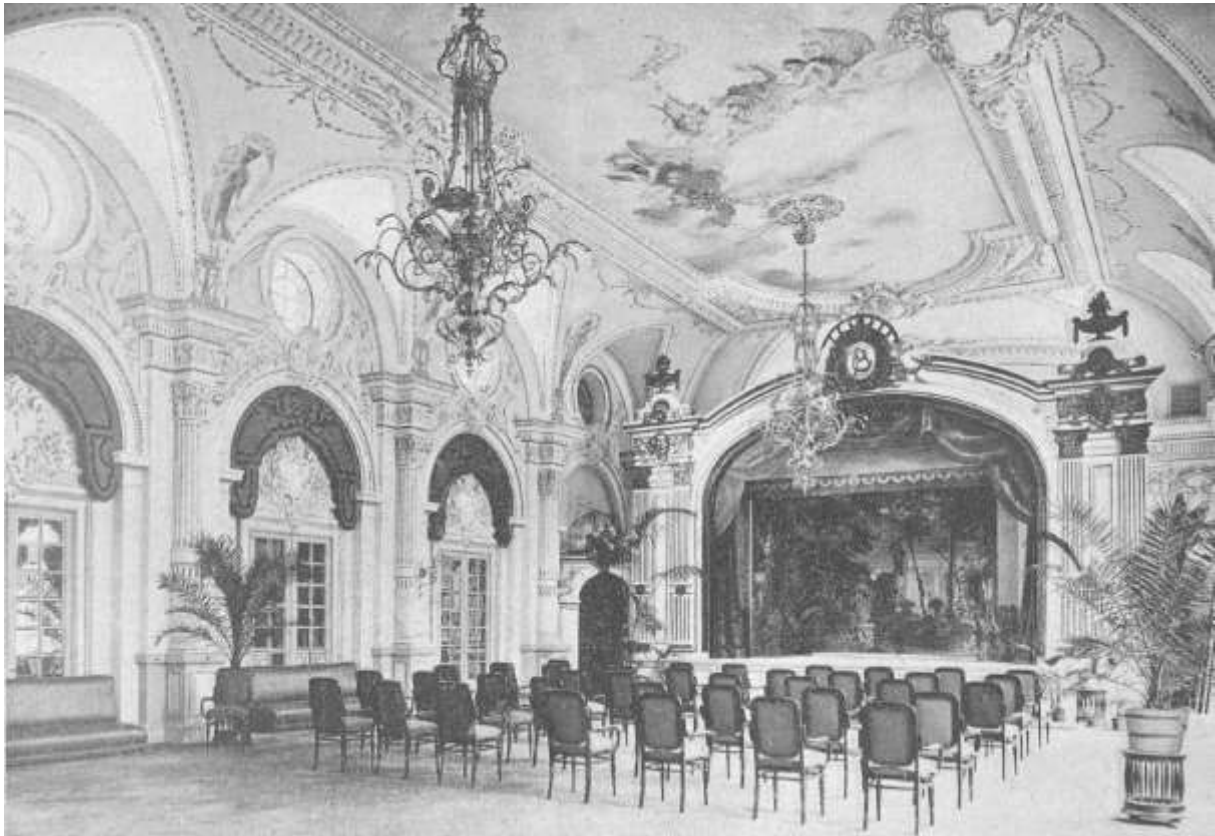
Fig. 14. La salle des fêtes, avant la construction d'une nouvelle scène et la pose des gradins ( Bulletin technique de la Suisse romande, op. cit. , p. 246). Les stucs au-dessus des portes, les peintures dans le départ des voûtes et au plafond ont disparu.
