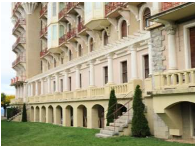
Fig. 33. Face sud de l'aile ouest.
