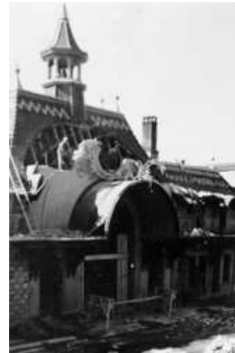
Fig. 122. Démolition de l'entrée en 1947 (Caux-Palace).
