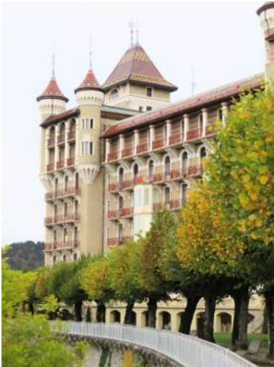
Fig. 31. Face sud de l'aile ouest.
