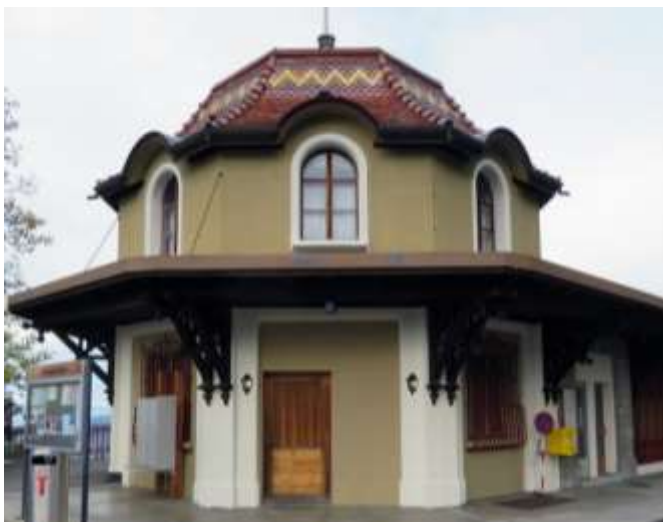
Fig. 50. Extrémité sud du promenoir intérieur.
