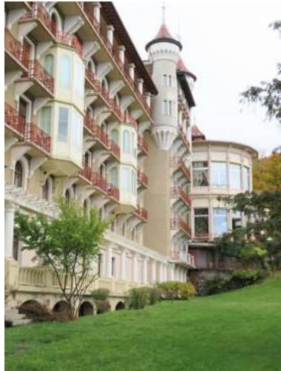
Fig. 32. Face sud de l'aile ouest.
