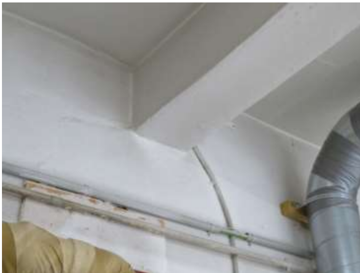
Fig. 29. Rez-de-chaussée, système porteur des planchers.
