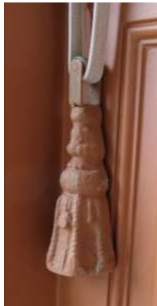
Fig. 91. Contre-poids de la commande des stores pour les salons privés.
