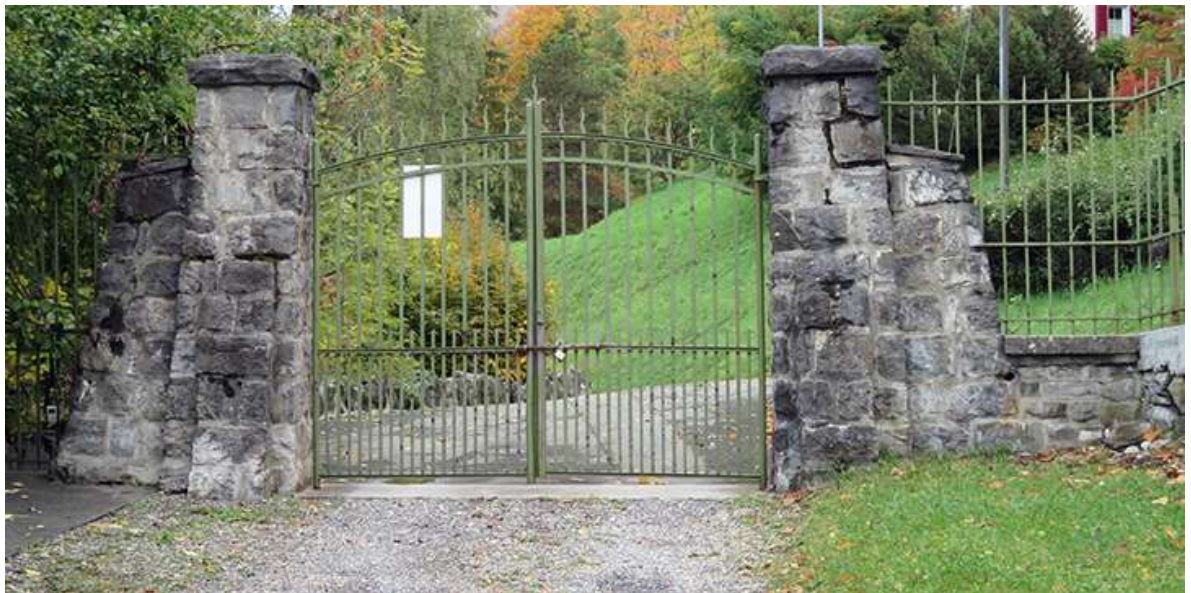
Fig. 110. Portail au nord, donnant sur la route cantonale.
