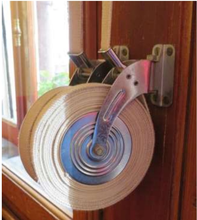
Fig. 85. Réception, ruban de commande des stores.
