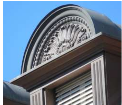
Fig. 47. Lucarne, façade est.
