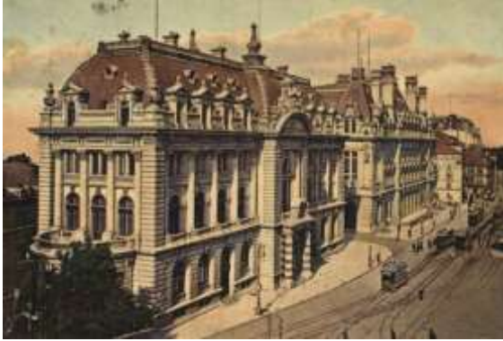
Fig. 61. Banque cantonale vaudoise, 1903, Francis Isoz architecte (vers 1915, s.n., MHL, P.2.M.A.1.S.5.204).
