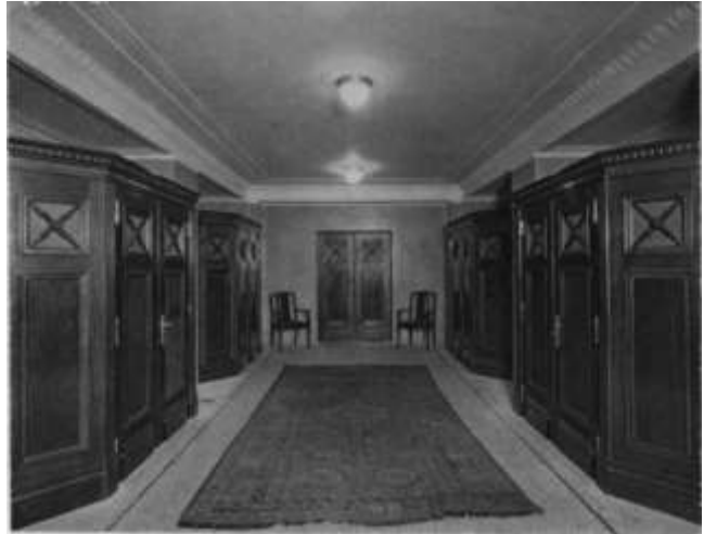
Fig.57. Cabines d'isolement pour les coffres de location, 2 e sous-sol, 1923 (photo Gaston de Jongh, MHL P.1.A.1.S.5.114).
