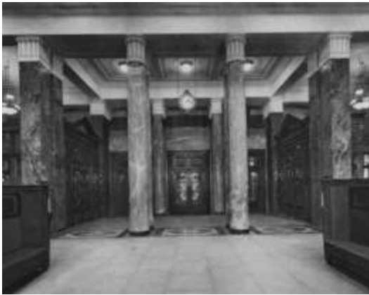
Fig. 52. Hall des guichets, rez-de-chaussée, en direction de l'entrée, 1923 (photo Gaston de Jongh, MHL P.1.A.1.S.5.112).
