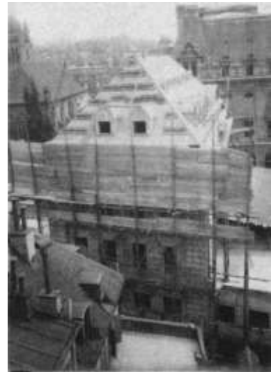
Fig. 24. Construction de la charpente en béton armé (Reportage photographique du chantier de construction, 1921, Archives UBS).
