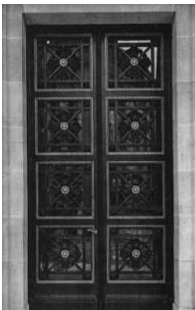
Fig. 41. Porte d'entrée, serrurerie Zwahlen et Mayr, décoration : Weitzel (photo Gaston de Jongh, Das Werk , 1924, 2, p. 47).
