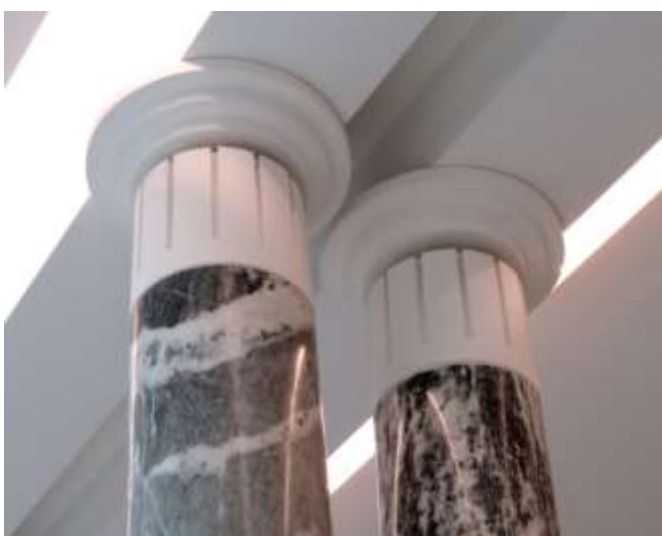
Fig. 73. Chapiteaux du hall en 2022.
