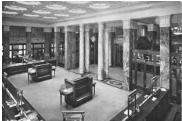
Fig. 53. Hall des guichets, rez-de-chaussée, 1923 (photo Gaston de Jongh, MHL P.1.A.1.S.5.113).
