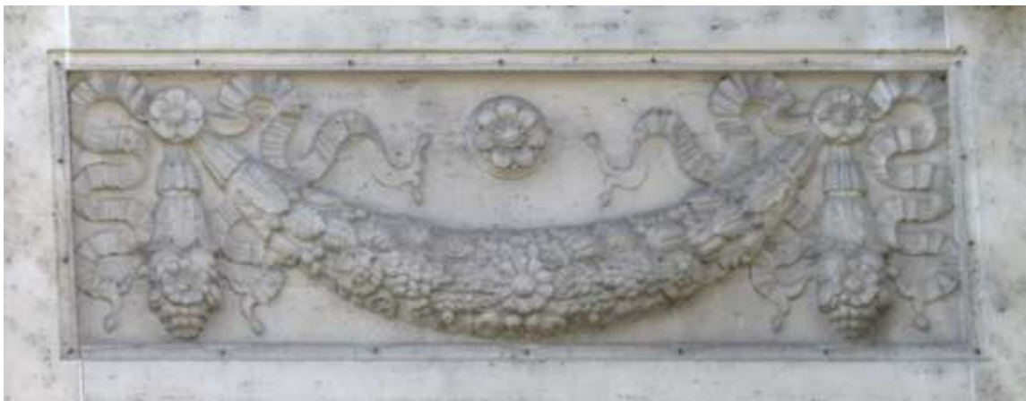
Fig. 36. Guirlande, façade nord.
