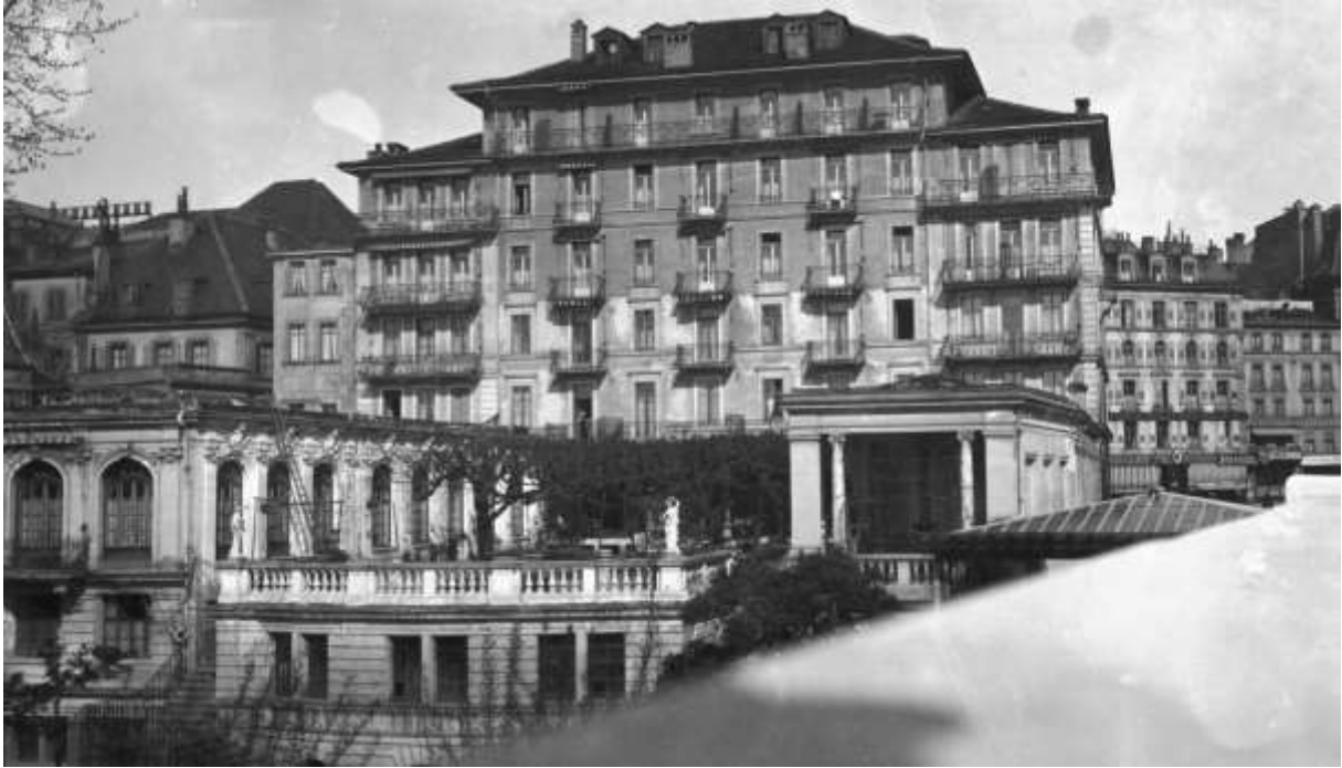
Fig. 4. Othmar Dufour, vue sur l'hôtel Gibbon depuis le sud, photographie, 1920 (MHL).
