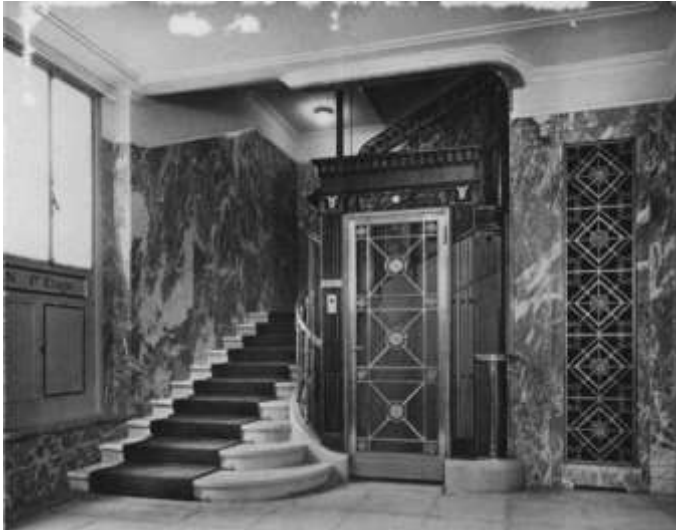
Fig. 50. Escalier de la direction, rez-de-chaussée, 1923 (photo Gaston de Jongh, MHL P.1.A.1.S.5.110).
