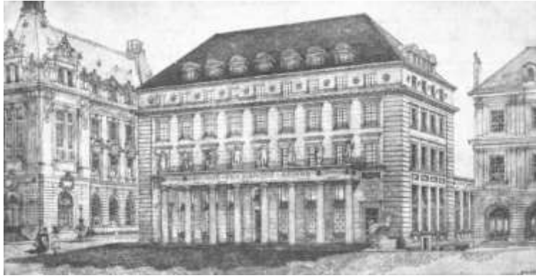
Fig. 7. Façade principale, Maurice Schnell et Charles Thévenaz architectes ( BTSR , 1920, 11, p. 125).
