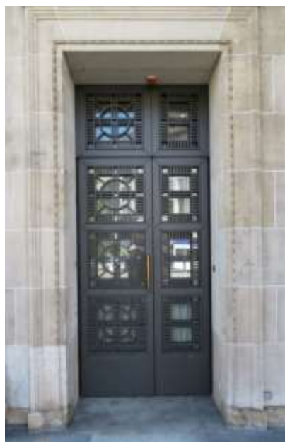
Fig. 42. Porte latérale, façade nord.
