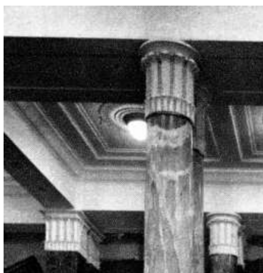
Fig. 74. Chapiteaux du hall en 1923 (photo Gaston de Jongh, détail, MHL P.1.A.1.S.5.112).
