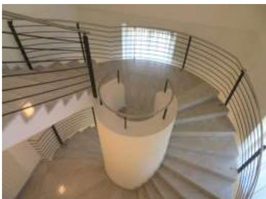
Fig. 75. Nouvel escalier dans l'angle nord-est, niveau des combles, 2022.
