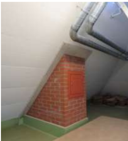
Fig. 25. Couverture en béton armé, sur-combles, 2022.
