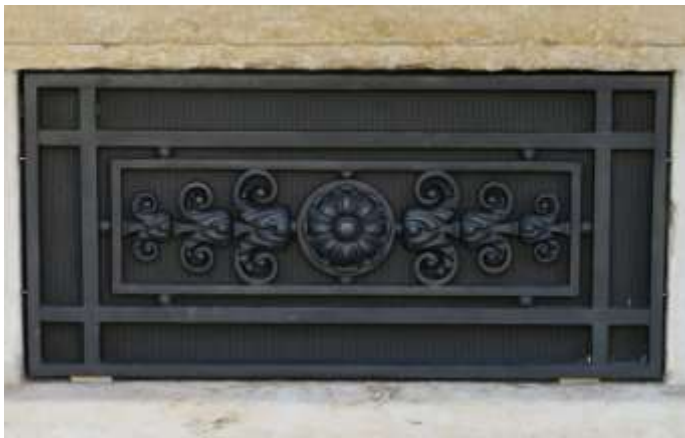
Fig. 46. Sopirail, façade nord.
