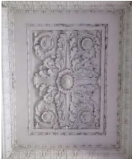
Fig. 34. Plafond du portique, façade nord.
